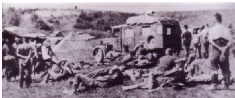
Abb. 87: Warteraum vor dem Hauptverbandplatz [25]
