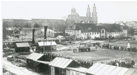
Abb. 43: Die Prinz-Franz-Kaserne an der Rottachstraße beim Bau 1935/1936 [4]
