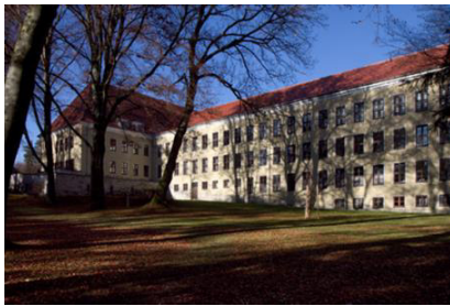
Abb. 139: Die Sanitätseinrichtung vom Park aus im Jahr 2014/2016 [12]
