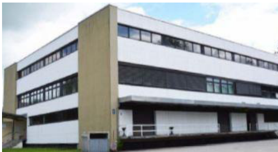
Abb. 61: Das Hauptgebäude der militärischen Liegenschaft Hinterm Siechenbach [6]
