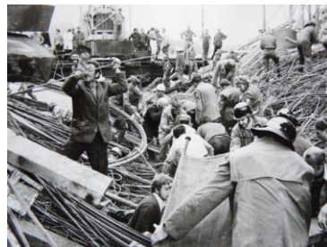
Abb. 309: Die eingestürzte Autobahnbrücke über die Leubas [167]
