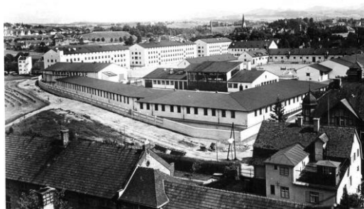
Abb. 45: Die Prinz-Franz-Kaserne nach der Renovierung 1956 [6]
