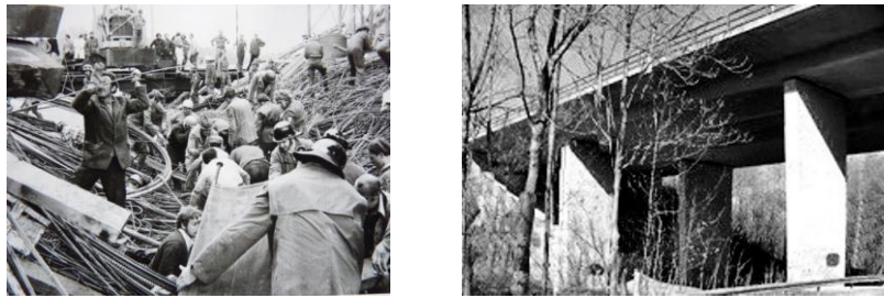
Abb. 184: Die Unglücksstelle und die Brücke heute (v. l.) [41]
