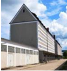
Abb. 222: Die Liegenschaft an der Ulmer Straße [12]
