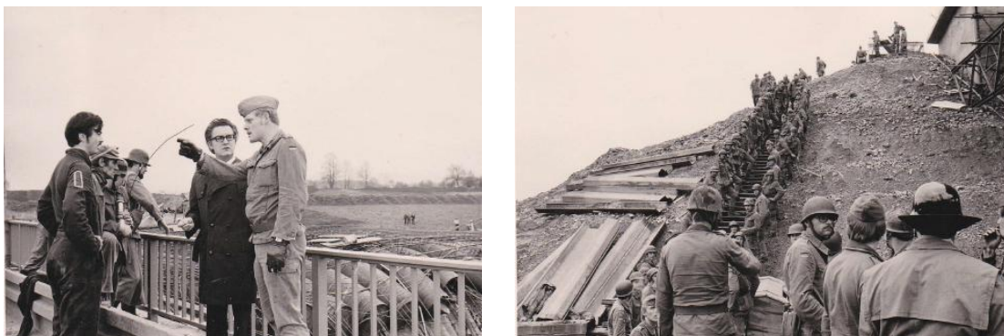
Abb. 246: Einsatz beim Einsturz der Leubas-Brücke am 30. April 1974 [2]
