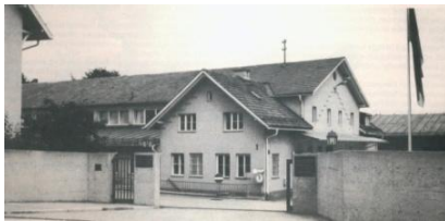
Abb. 220: Die Liegenschaft an der Haubenschloßstraße [12]
