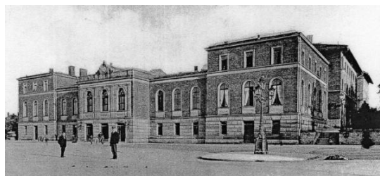
Abb. 187: Empfangsgebäude des Kemptener Kopfbahnhofs von 1888 [16]
