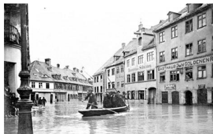
Abb. 193: Hochwasser der Iller in Kempten 1910, Bäckerstraße [16]
