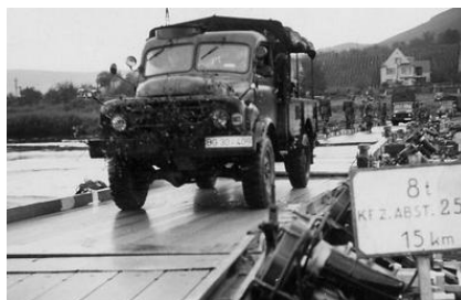
Abb. 94: Der Bundesgrenzschutz bei einem Brückenschlag [2]
