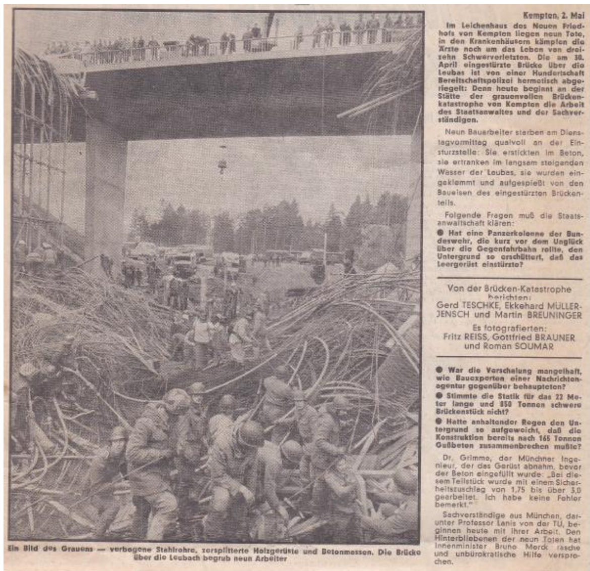
Abb. 245: Einsatz beim Einsturz der Leubas-Brücke am 30. April 1974 [2]
